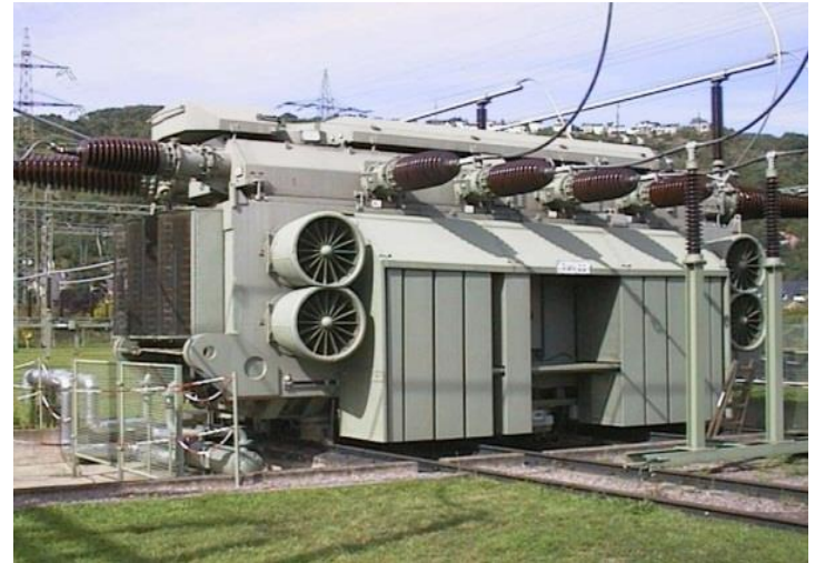
Kép: Az első PDM berendezés egy 400 kV-os hálózati transzformátoron (RWE) 1998
