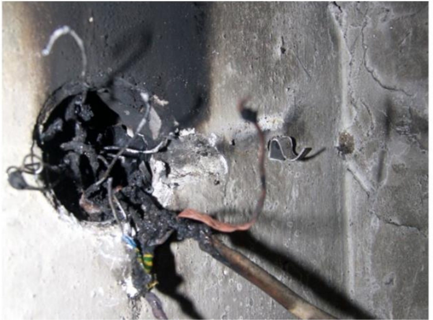
5. kép: A tűz keletkezésének oka: alumínium és réz vezetékek összesodorva
