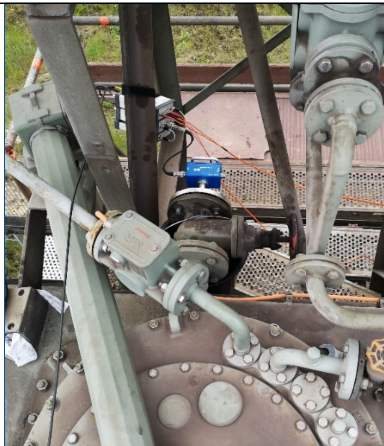
Felső olajtöltő szelep UHF mérőrendszerrel
