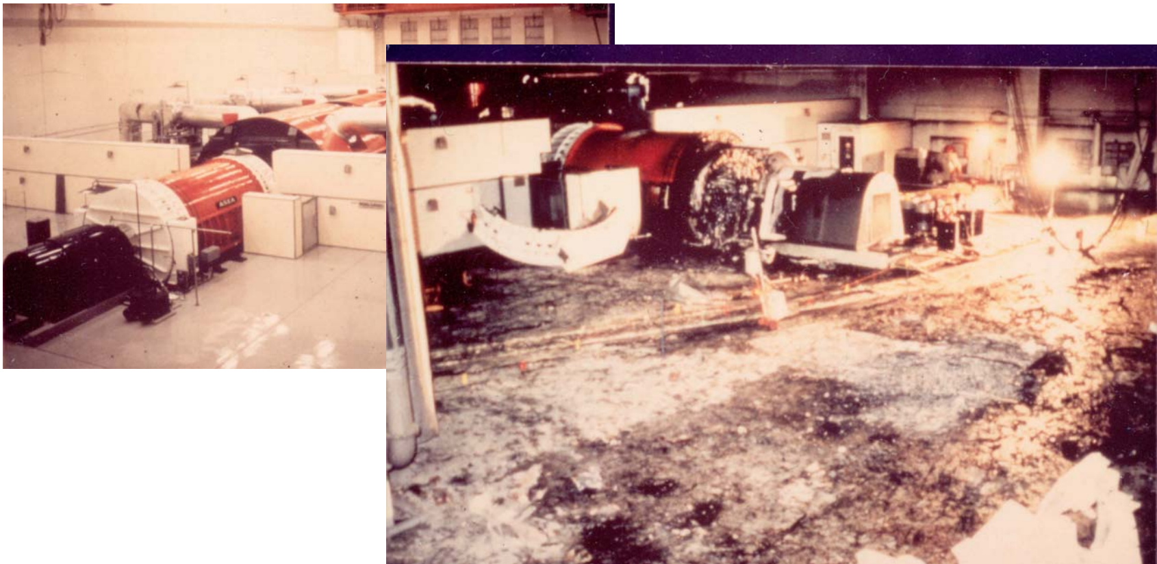
Gépház bandázssapka törés előtt és után
