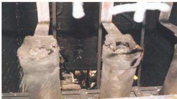
Végelzáró öregedése
